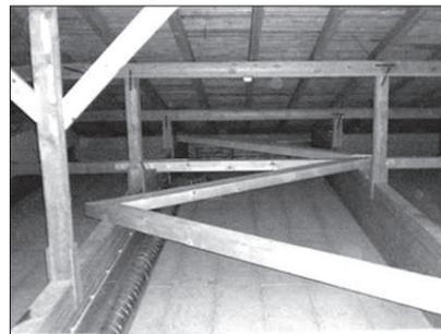
Im Bild oben: Statische Verbesserungsarbeiten der Konstruktion
